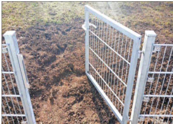
Eingangstür lässt sich nur im spitzen Winkel öffnen
