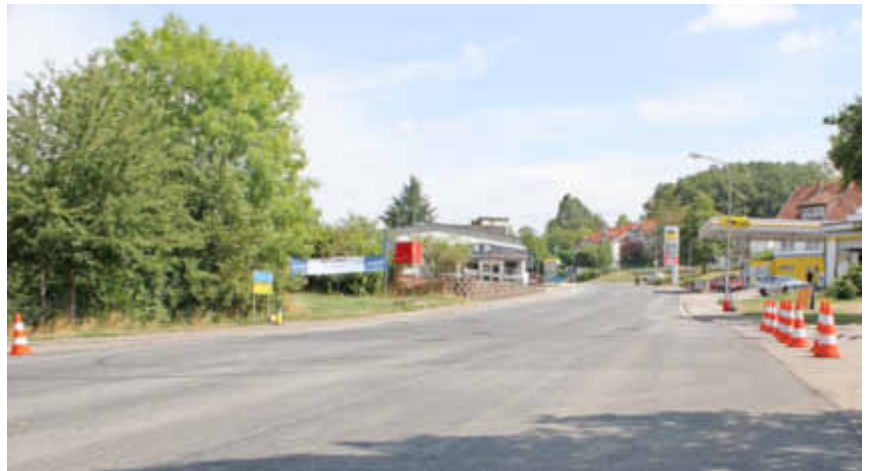
Frisch asphaltiert: Die L127/Talstraße in Fischbach, Höhe Tankstelle.
