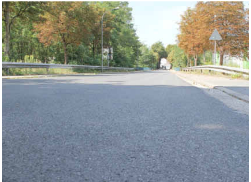
Die neue Fahrbahnoberfläche der L262 im Bereich Bahnhofstraße.
