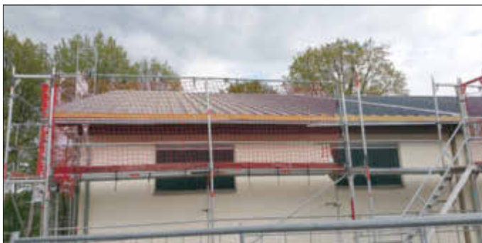
Dacharbeiten an der Schulturnhalle Fischbach
